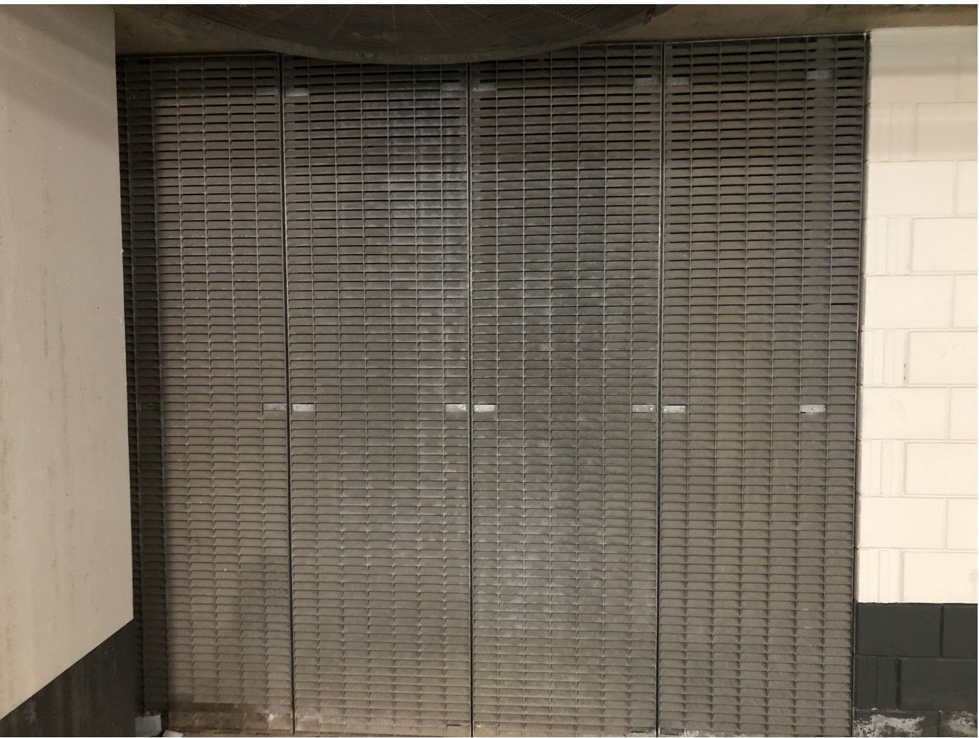
Lamellenrooster van buitenaf gezien Type: Staco RL 30-2/99.99x44.44 S235JR Conservering: Verzinkt en 2-laags gecoat Zwartgrijs RAL 7021 matte gloss 30%
