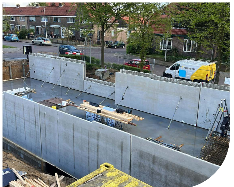
Bouwplaats On The Hill Arnhem
