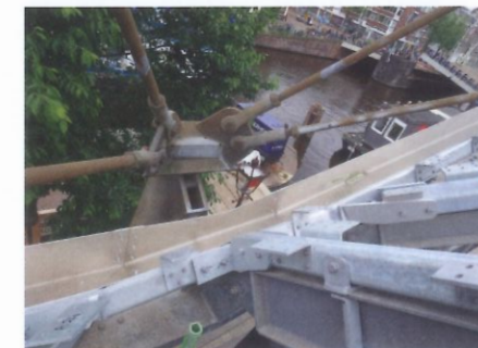
11. Boutverbindingen voor losmaakbaarheid.
